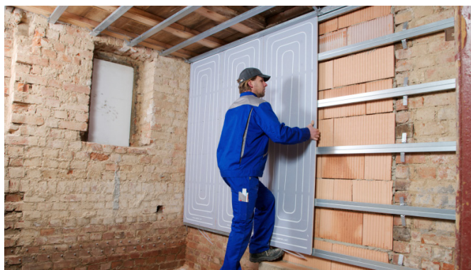
Instalace systému Reno při rekonstrukci stěn.
