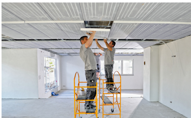
Instalace systému Reno jako stropní podhled.
