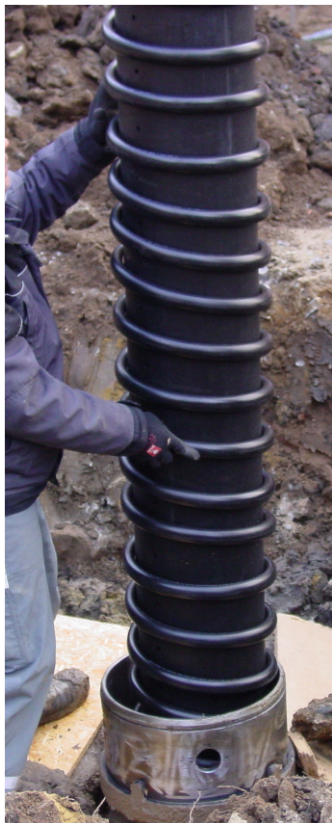
Instalace za pomoci dutého šnekového vrtáku.
