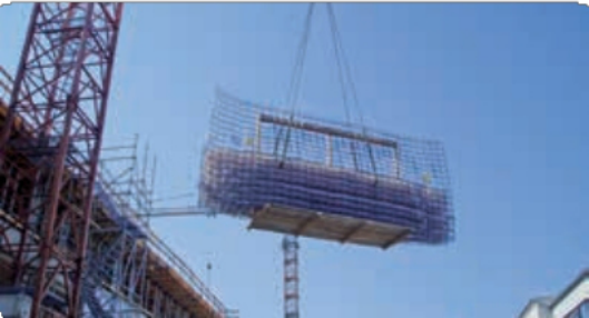
Správná přeprava modulu BATISO s vertikálními moduly pomocí jeřábu
