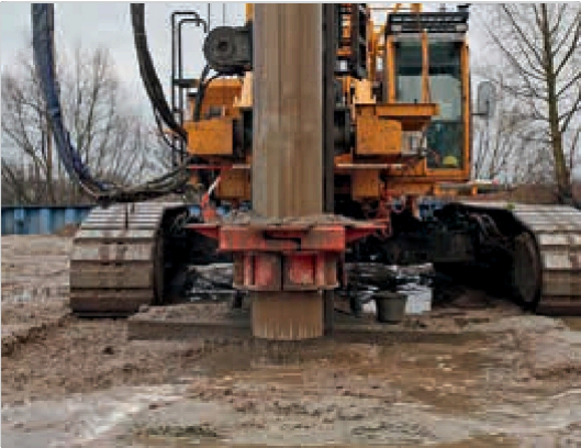
Montáž vrtané piloty
