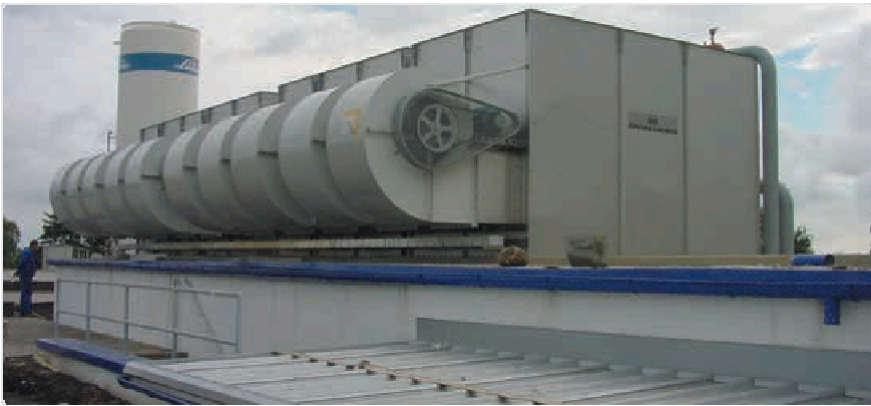
Využití rekuperačních jednotek pro výrobu studené vody
