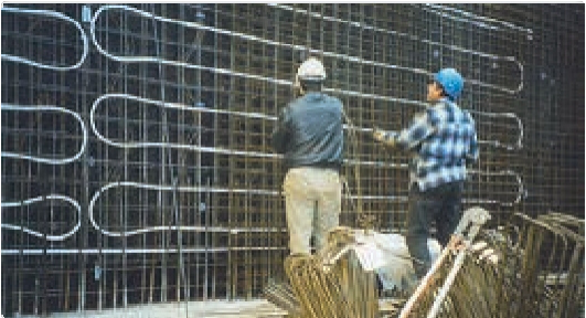
Moduly Geocore BATISO instalované ve zdi
