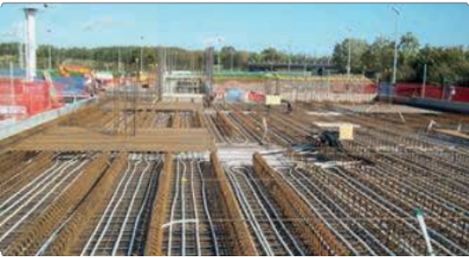
Podlahová část U-Boot® se systémem Geocore BATISO
