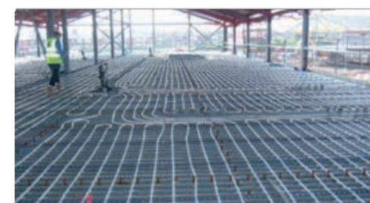
Geocore BATISO instalovaný v kovovém podkladu
