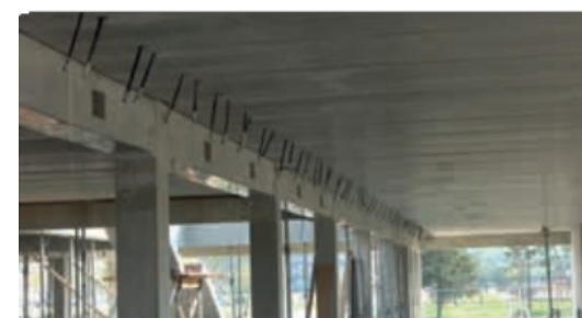
Moduly Geocore BATISO zabudované do prefabrikované duté desky
