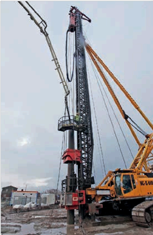
Postup betonování pilot in situ
