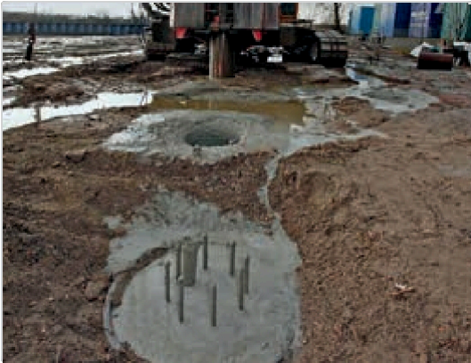
Prefabrikovaná betonová vrtaná pilota
