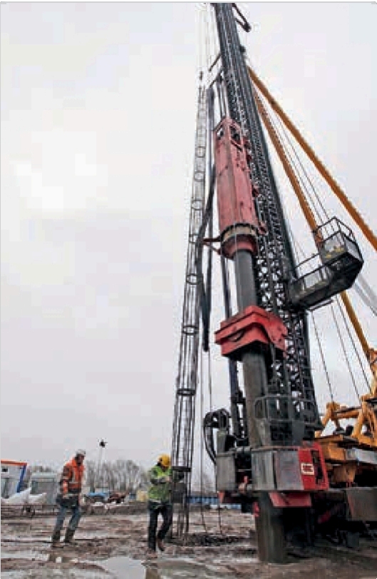
Instalace výztužných klecí
