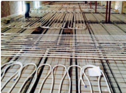
Instalace systému Geocore BATISO s žebrovanou deskou
