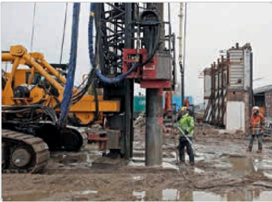
Dohled nad montáží pilot
