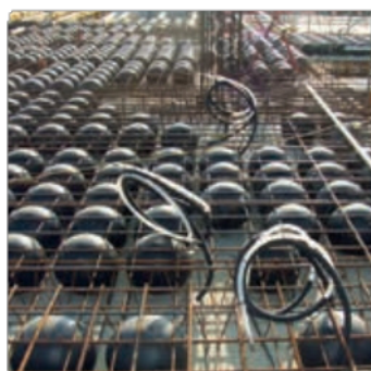
Chladicí systém Geocore TABS je integrován do konstrukce BubbleDeck®.
