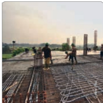
Instalace radiantního chlazení Geocore TABS
