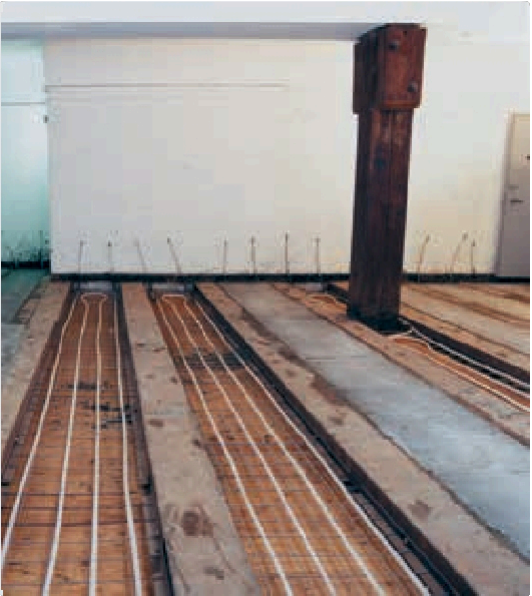
Instalace na míru mezi stropními trámy
