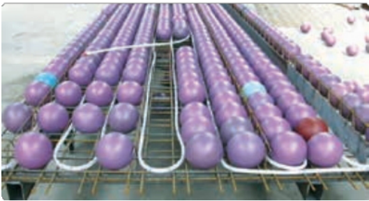
Moduly Cobiax® v kombinaci se systémem Geocore BATISO jako prefabrikované moduly
