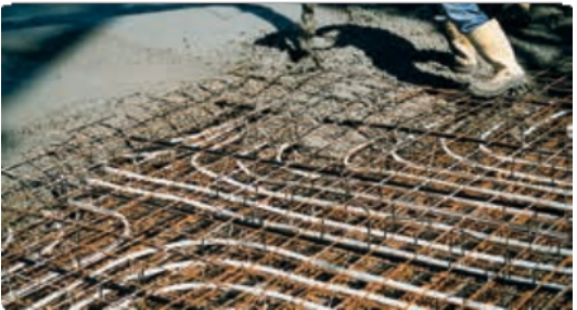
Lití betonu na místě
