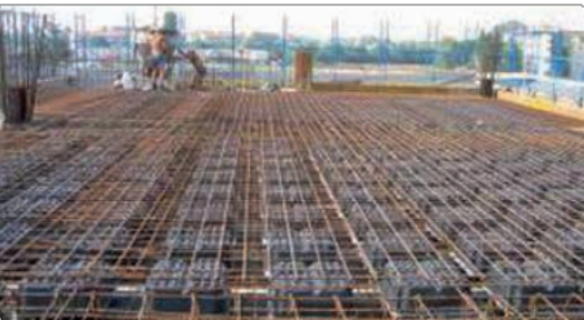
Instalace Geocore BATISO, betonování a instalace modulů U-Boot
