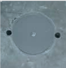
Pohled ze spodní strany na zapuštěnou zásuvku
