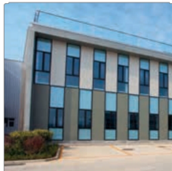
Budova s nulovými emisemi je sídlem správy závodu Bayer MaterialScience.
