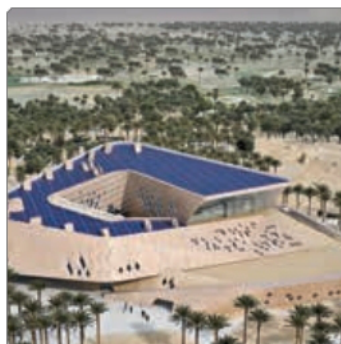
Vysoké chladicí výkony 1,5 MW jsou dodávány hlavně ze systému Geocore TABS o rozloze 7 500 m².
