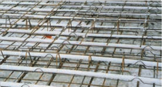
Moduly Geocore BATISO umístěné na síťových nosičích
