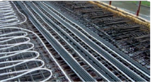
Moduly Geocore BATISO se instalují do středu podlahy.
