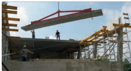
Jefáb přepravující prefabrikovaný betonový panel na správné místo
