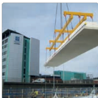
13 500 m 2 chlazení Geocore TABS v poloprefabrikovaných betonových deskách
