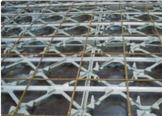
Standardní verze BATISO ON instalovaná blízko povrchu stropu na bednění
