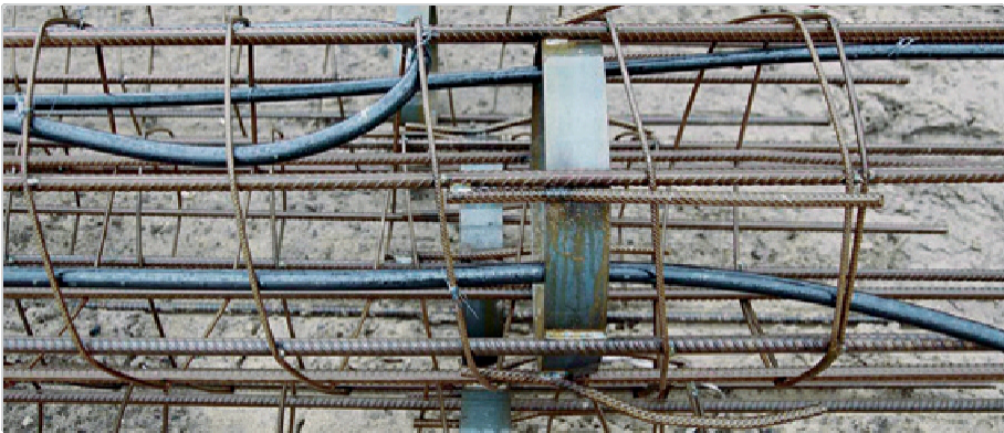
Skladování namontovaných výztužných klecí
