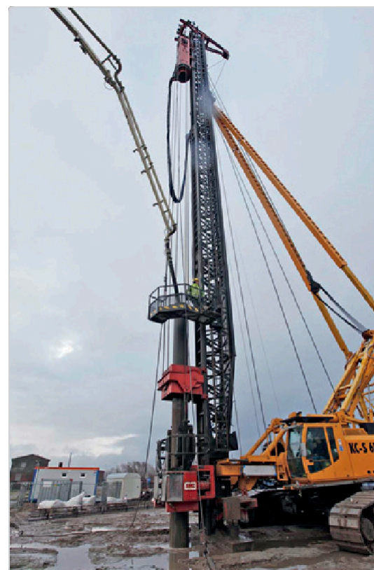
Postup betonování pilířů na místě
