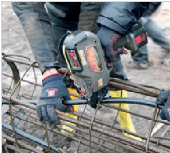
Upevnění trubkových smyček
