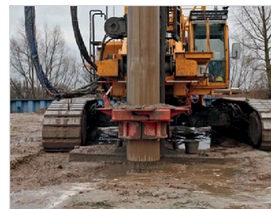
Montáž vrtané piloty
