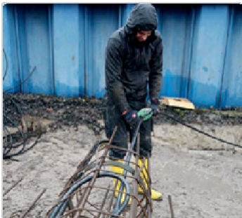
Řezání vložených trubkových smyček na délku
