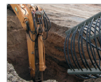
Výkop instalační jámy
