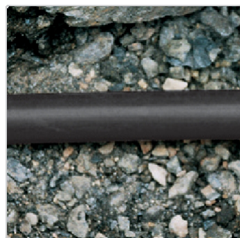
Pokládání trubek PE-Xa bez pískového lože
