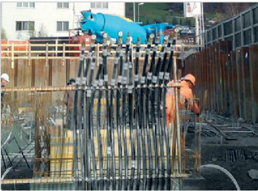
Tlaková zkouška instalací energetických pilířů
