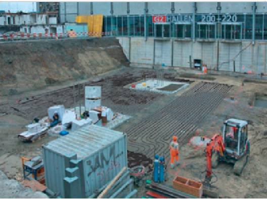
Vytvoření kolektoru z podlahové desky
