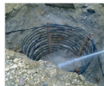
Zmytí výplňového materiálu
