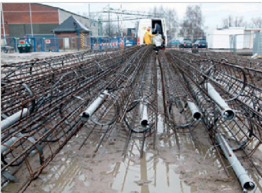
Skladování namontovaných výztužných klecí
