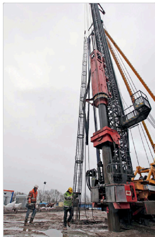
Instalace výztužných klecí
