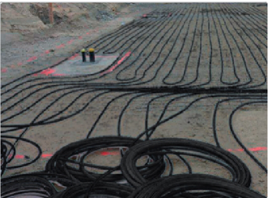
Pokládání jednotlivých trubkových smyček
