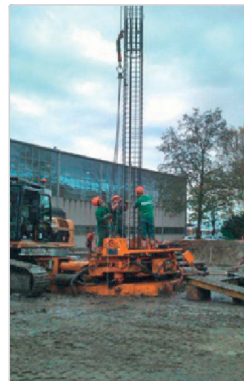
Vložení ocelové výztužné klece do vrtu
