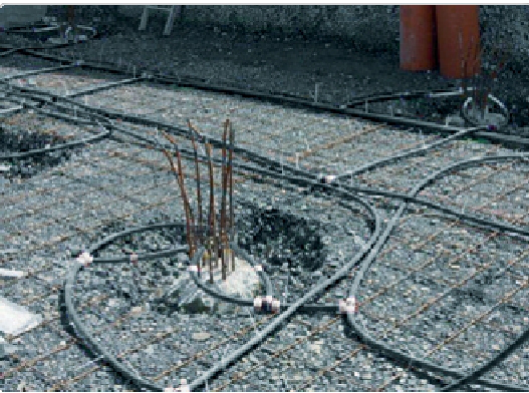
Připojení energetických pilířů pomocí trubek Uponor PE-Xa
