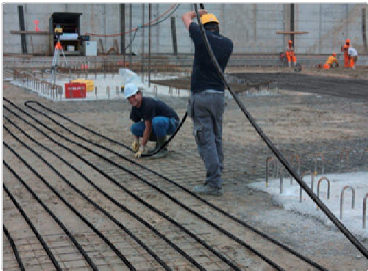
Upevnění trubkových smyček na výztužné síťoviny
