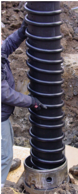
Instalace za pomoci dutého šnekového vrtáku.
